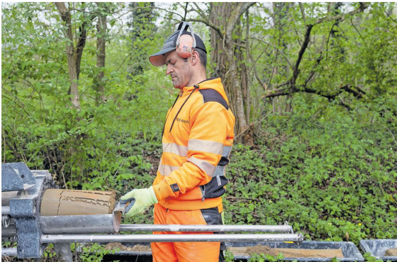
Auf der Suche nach Kies: Der Spezialbohrer macht das Bodenprofil bis in sieben Meter Tiefe sichtbar.
